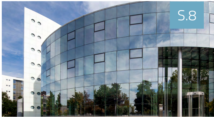
Neues, hochmodernes CADENAS Bürogebäude in Augsburg als Basis für weiteres Wachstum
